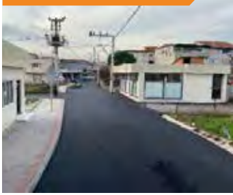
Yol Bakım Onarım İşleri
